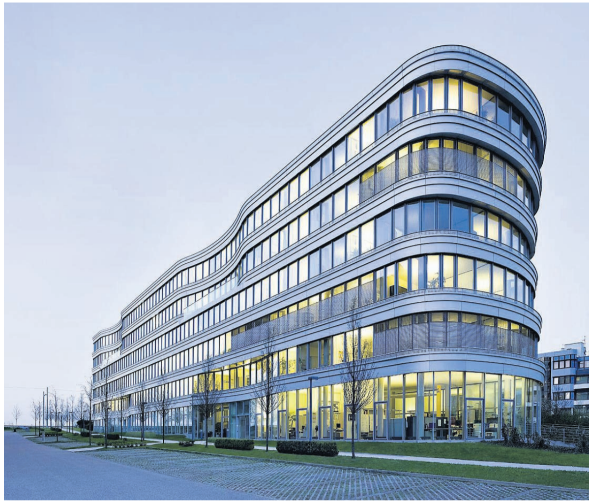
„Z-zwo“ in Stuttgart-Möhringen ist eines der ersten Gebäude, die das Deutsche Gütesiegel für Nachhaltiges Bauen erhielten. FOTO: WILLEBRAND
